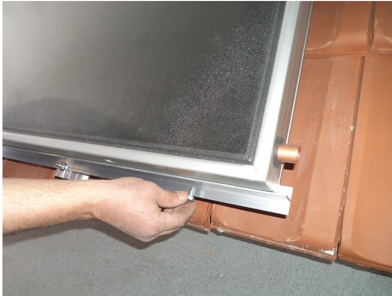
6. Solární kolektory jsou umístěny na profilech a upevněny šrouby (pohled zespodu)
