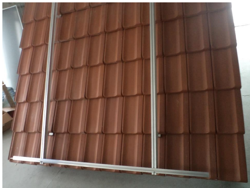
Pohled na postavenou konstrukci
