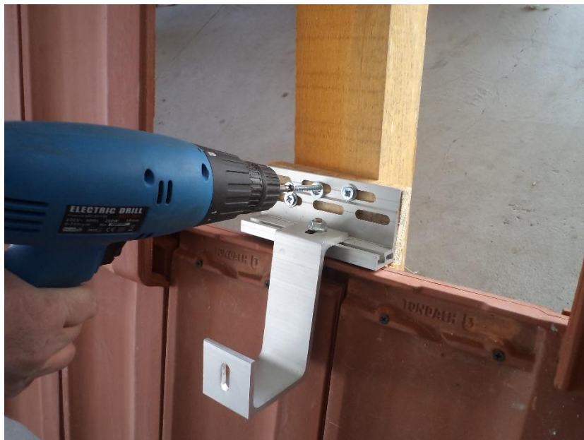
1. Držák je připevněn k dřevěnému trámu pomocí šroubů
