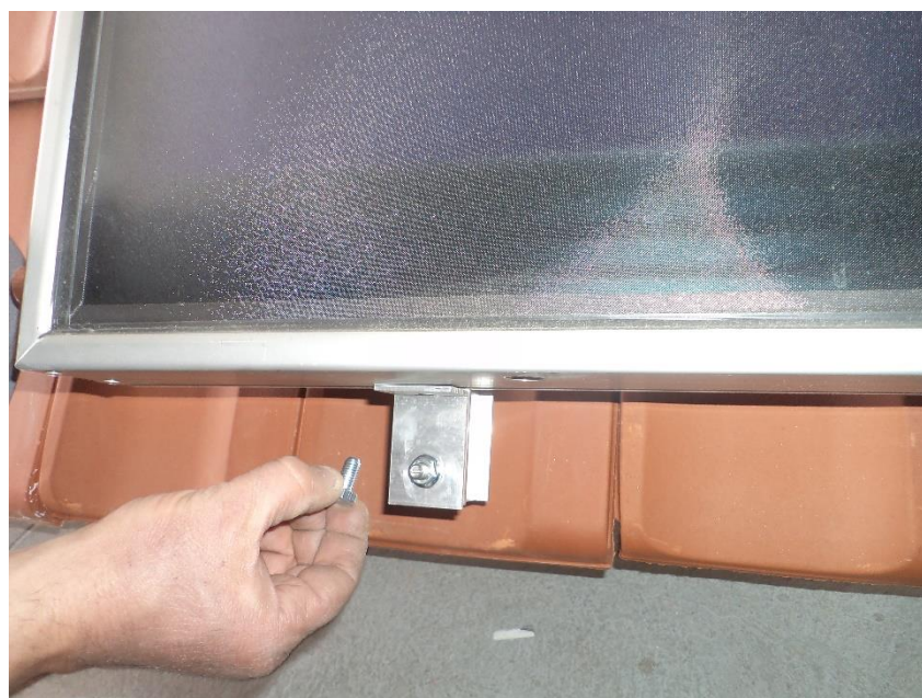
4. Solární kolektor se umístí na profily a upevní pomocí rohových konzol (pohled zespodu)
