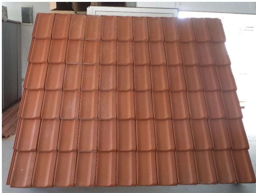
Pohled na střechu před montáží
